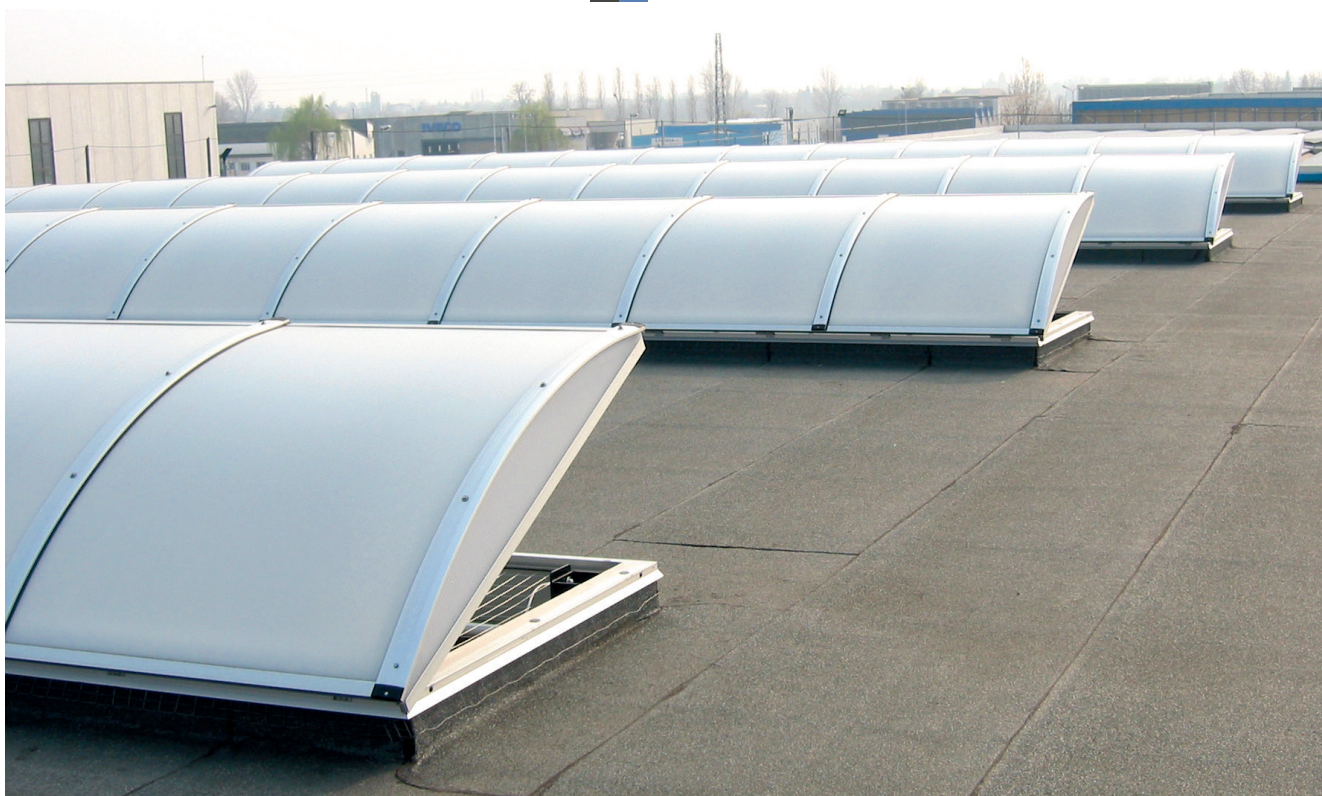
Esempio di distribuzione lucernari in copertura
