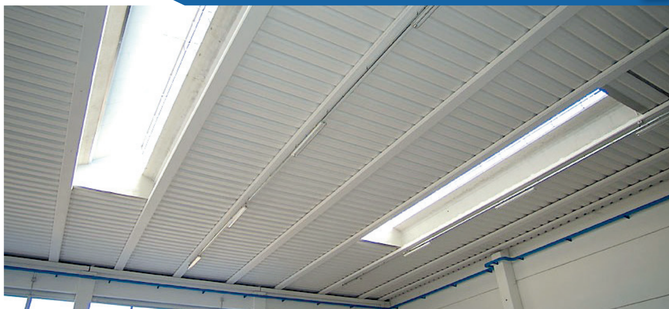
controsoffitto in fibrocemento NT su copertura a Y
