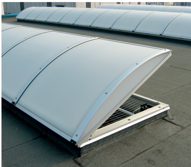
Lucernari su coperture piane tipo TT con impermeabilizzazione e coibetazione
