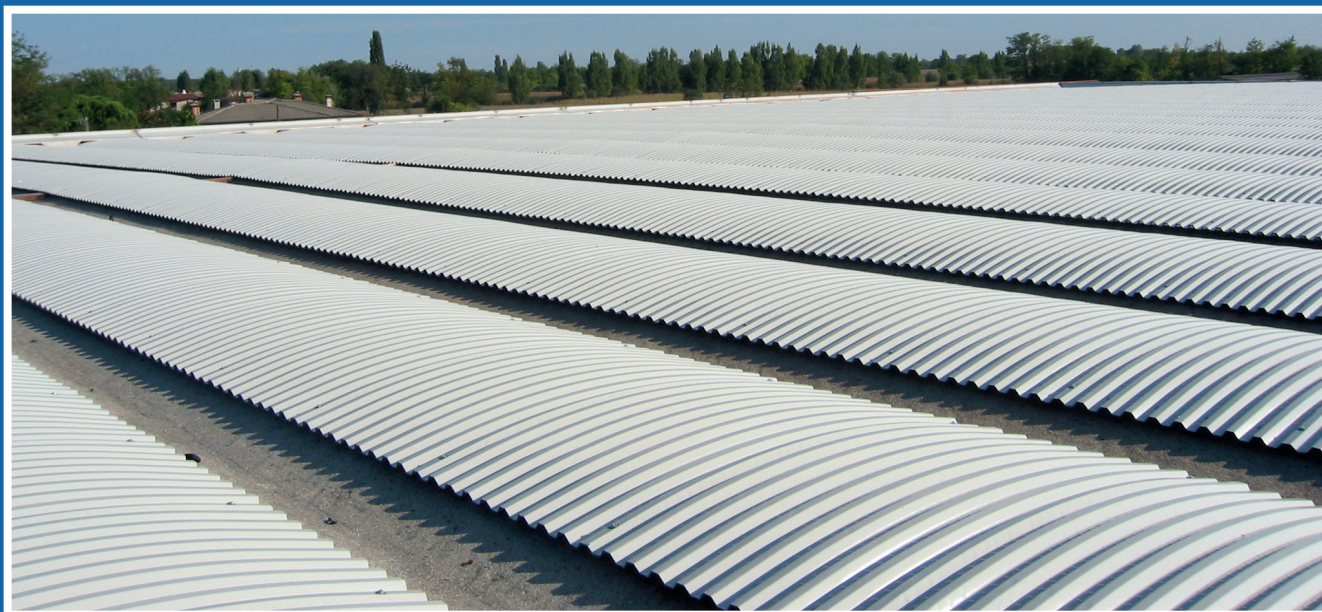
copertura metallica su copertura a Y
