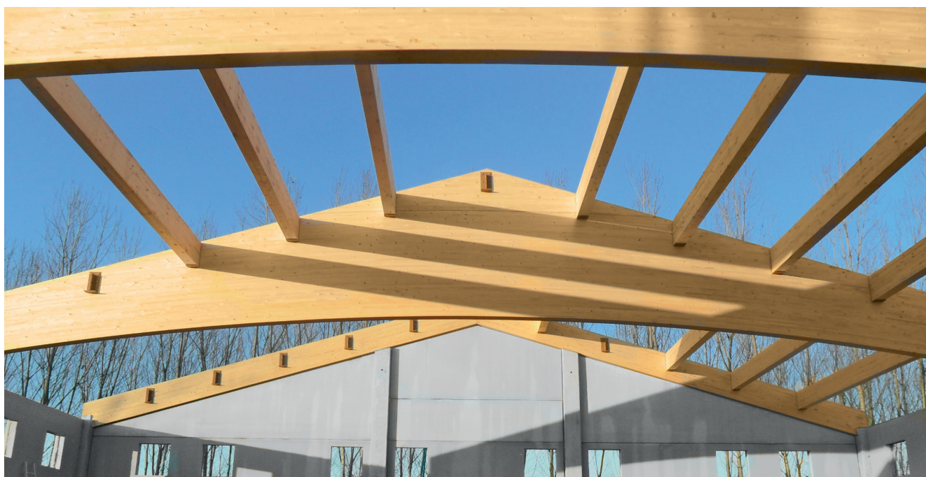
Copertura in legno lamellare
